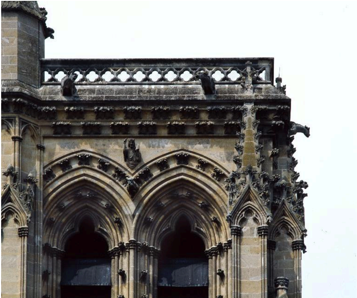
Détail du décor de la partie supérieure du clocher.
