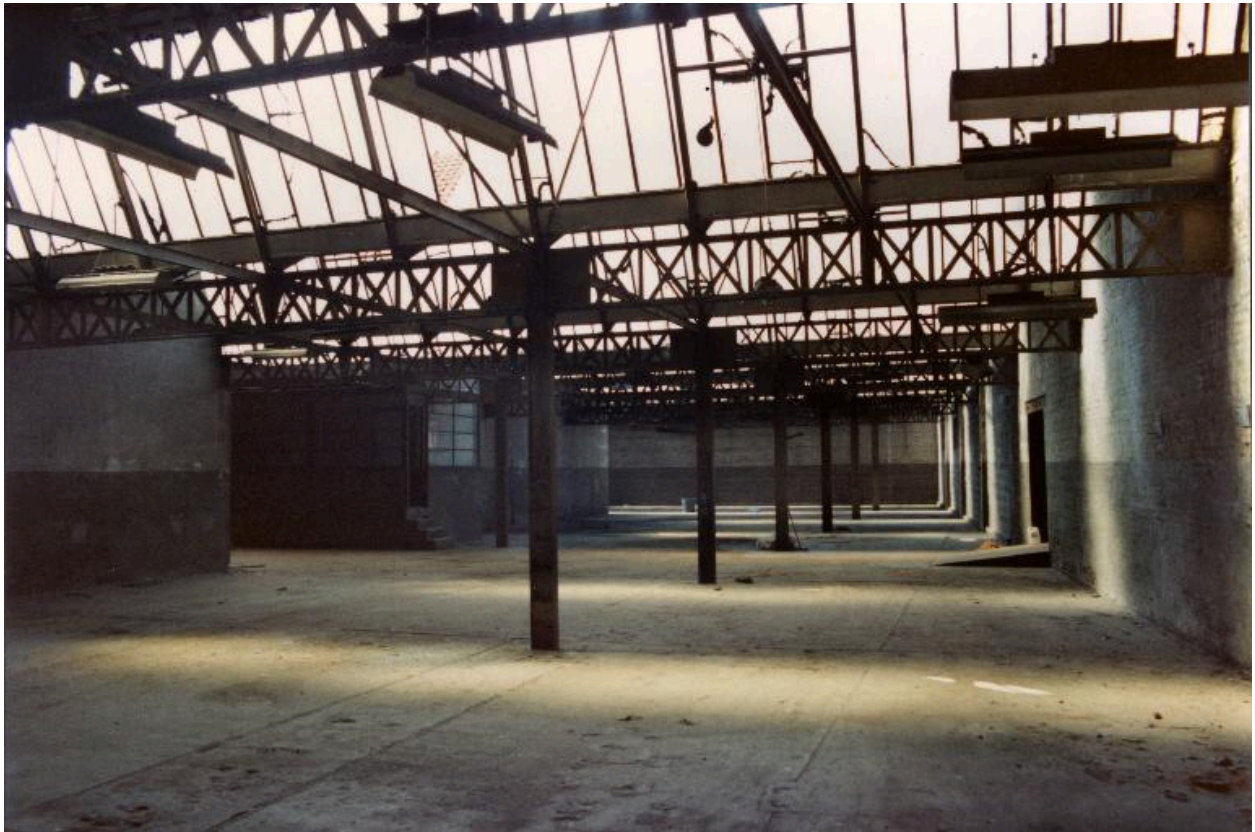
Anciens ateliers de fabrication, en 1990.
