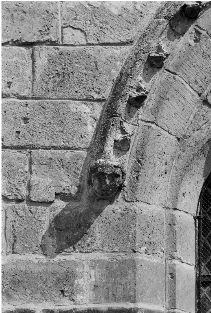
Détail de la moulure qui surmonte la fenêtre du bras sud du transept.
