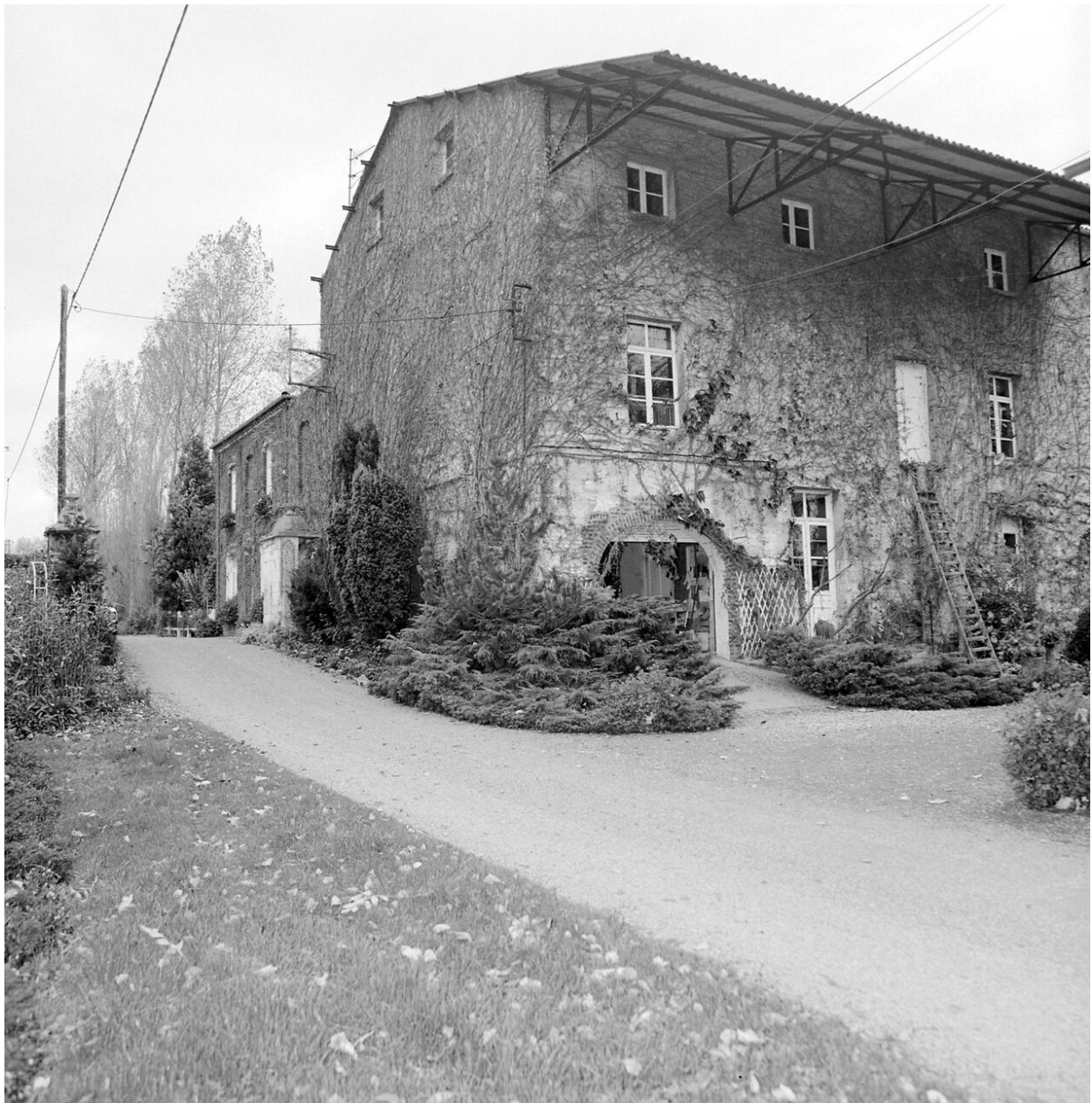
Atelier de fabrication : vue de trois quarts.
