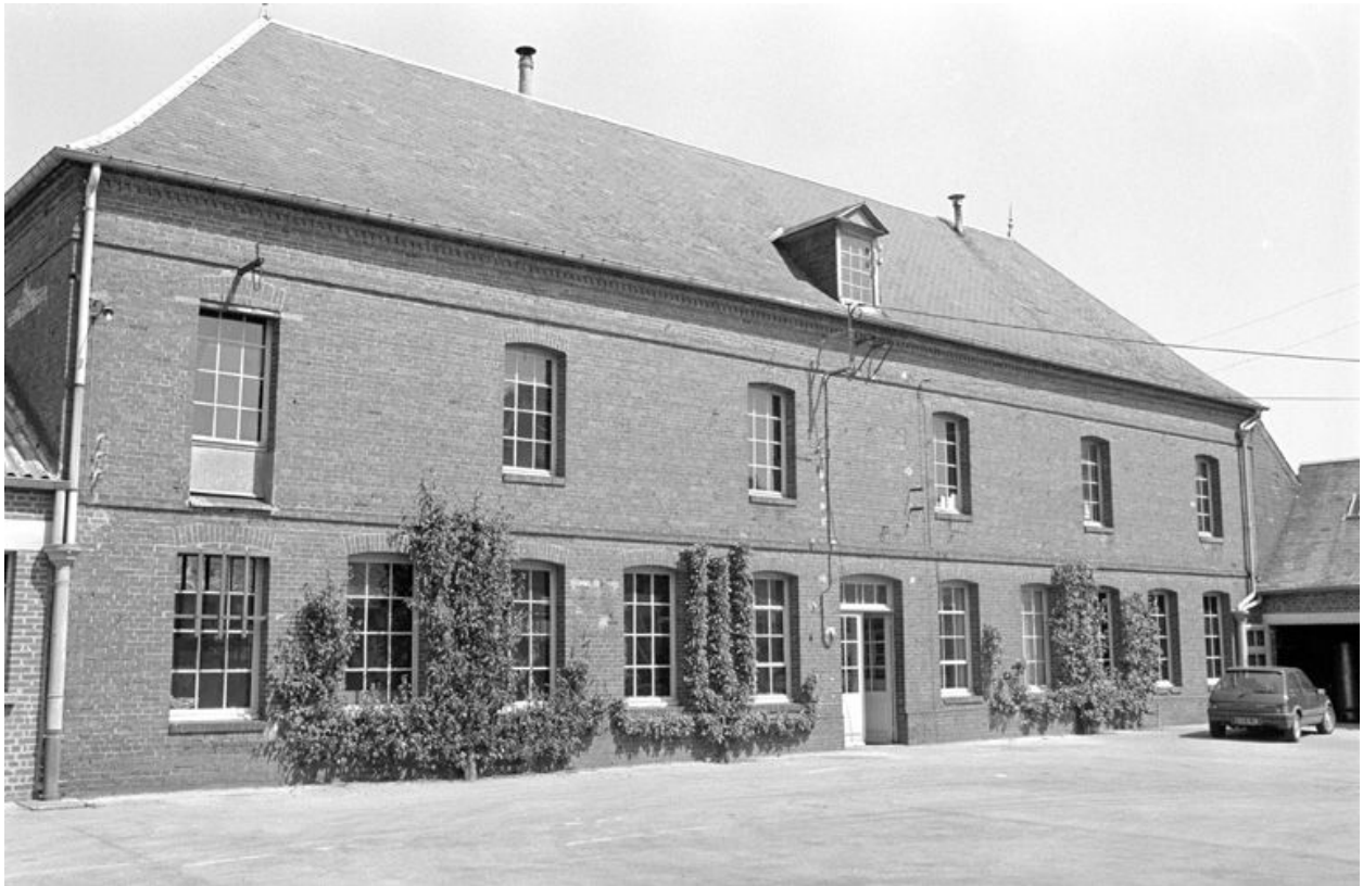
Atelier de fabrication, élévation antérieure, 1990.
