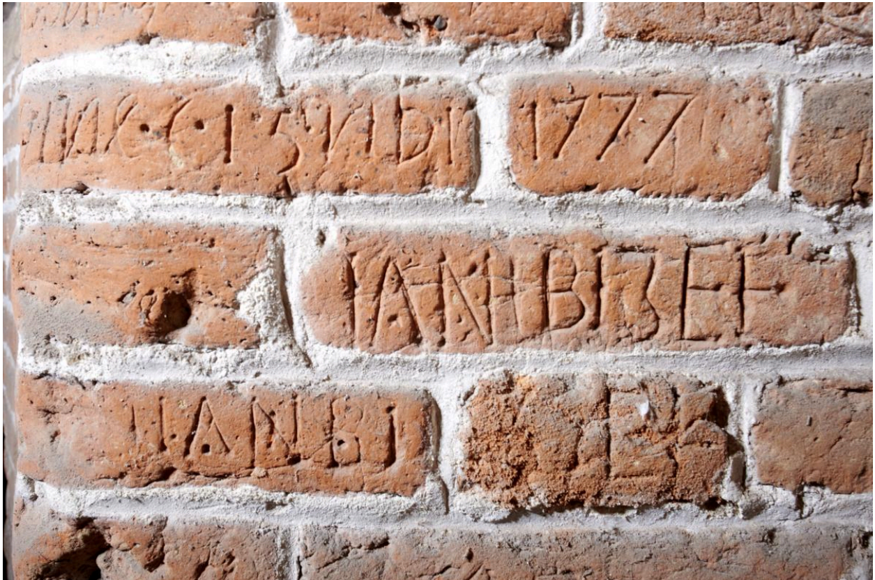
Niveau principal (R+1). Détails des gravures réalisées dans la briques (1777, noms).
