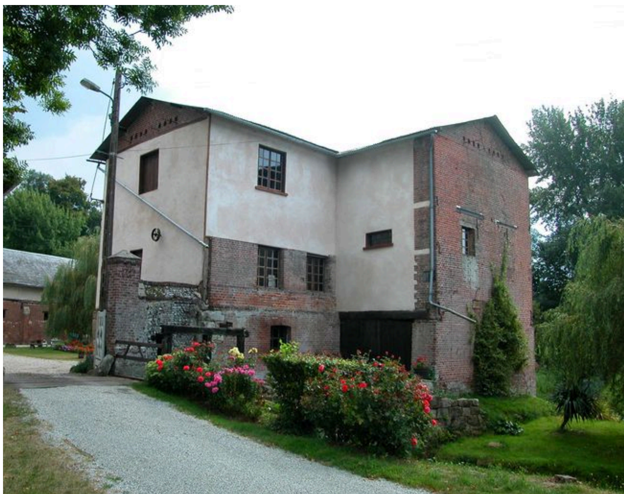
Ensemble occidental du moulin.
