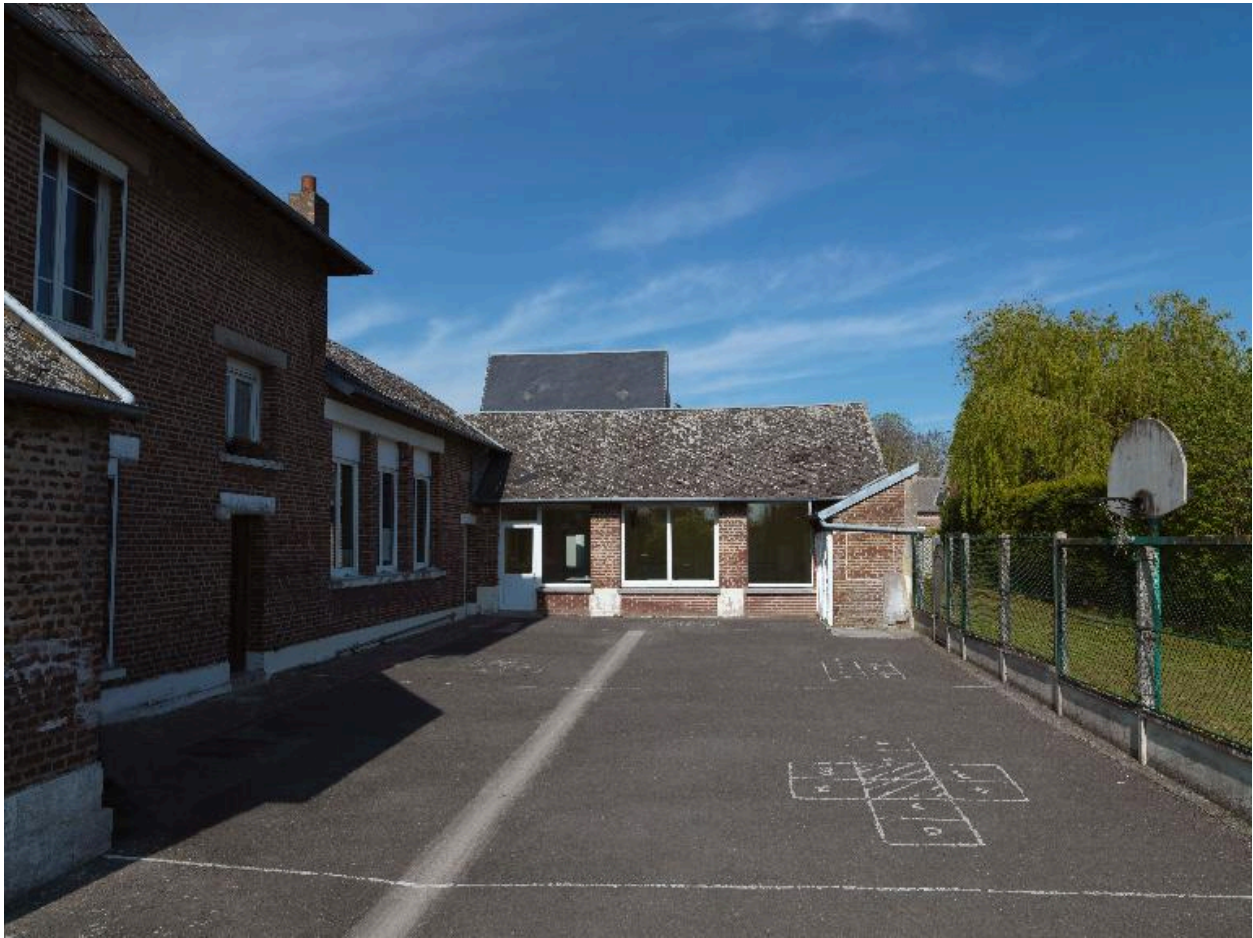
Vue depuis le sud-ouest, la cour, le préau et les sanitaires.
