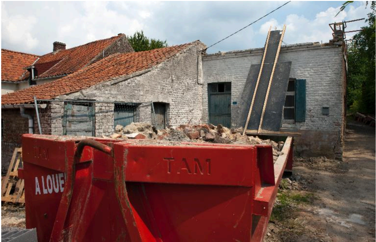
Vue générale de la maison élémentaire 3 rue du Trou-Marron en travaux (en 2012).
