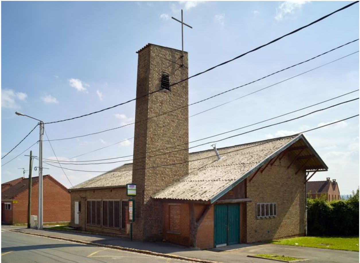
Vue de trois quart gauche de la chapelle.
