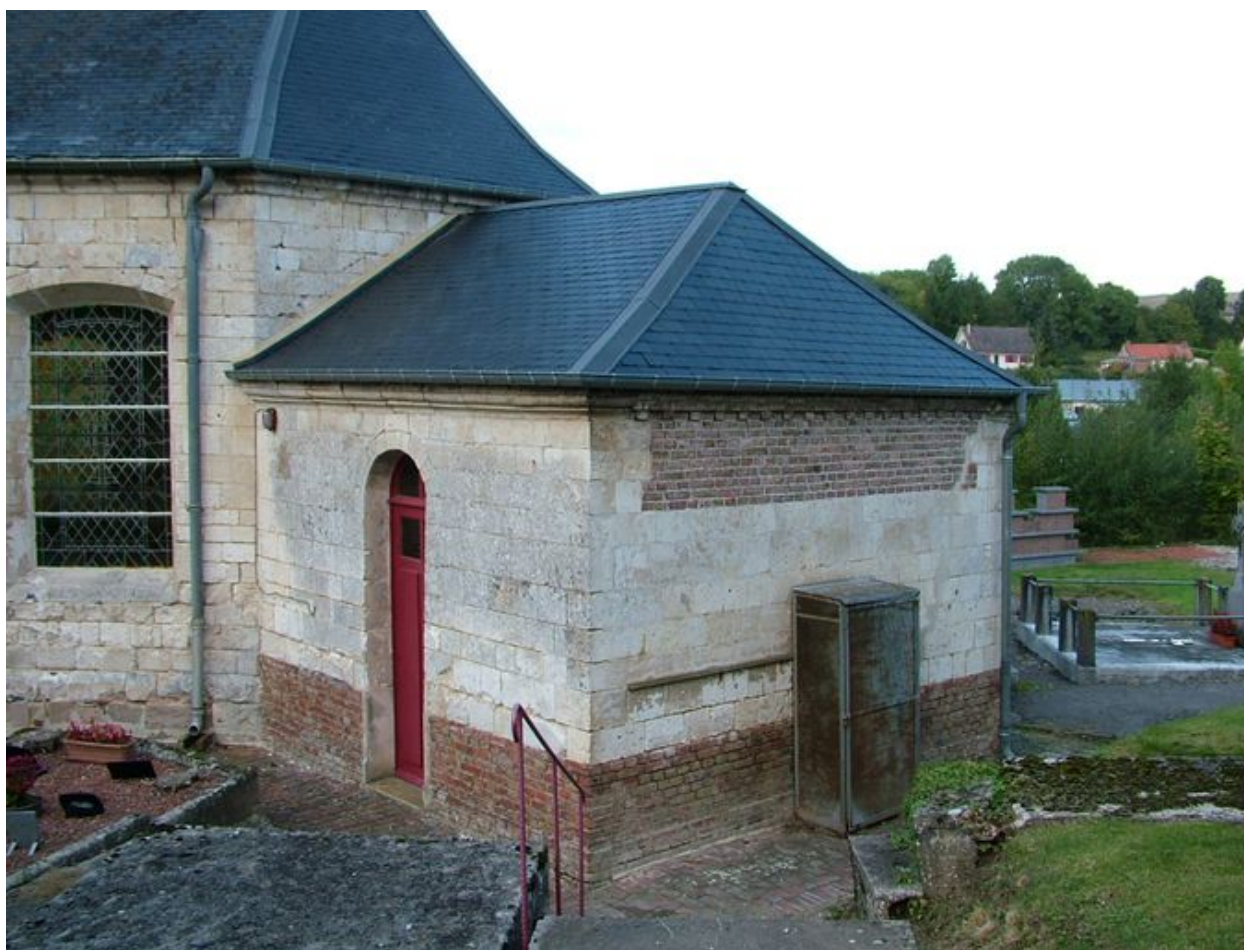
Sacristie jouxtant le chœur au sud-est.
