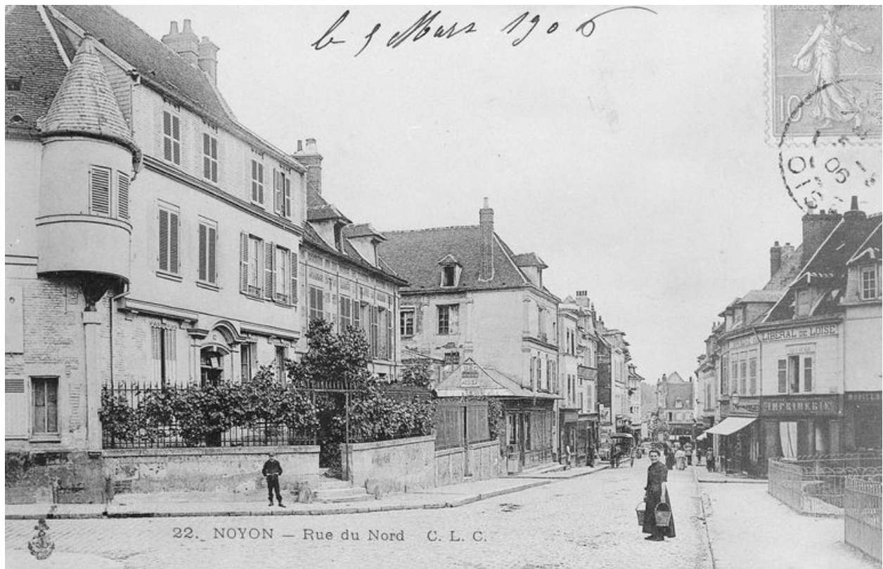
Rue du Général de Gaulle, vers le sud. Avant 1914 (AP).
