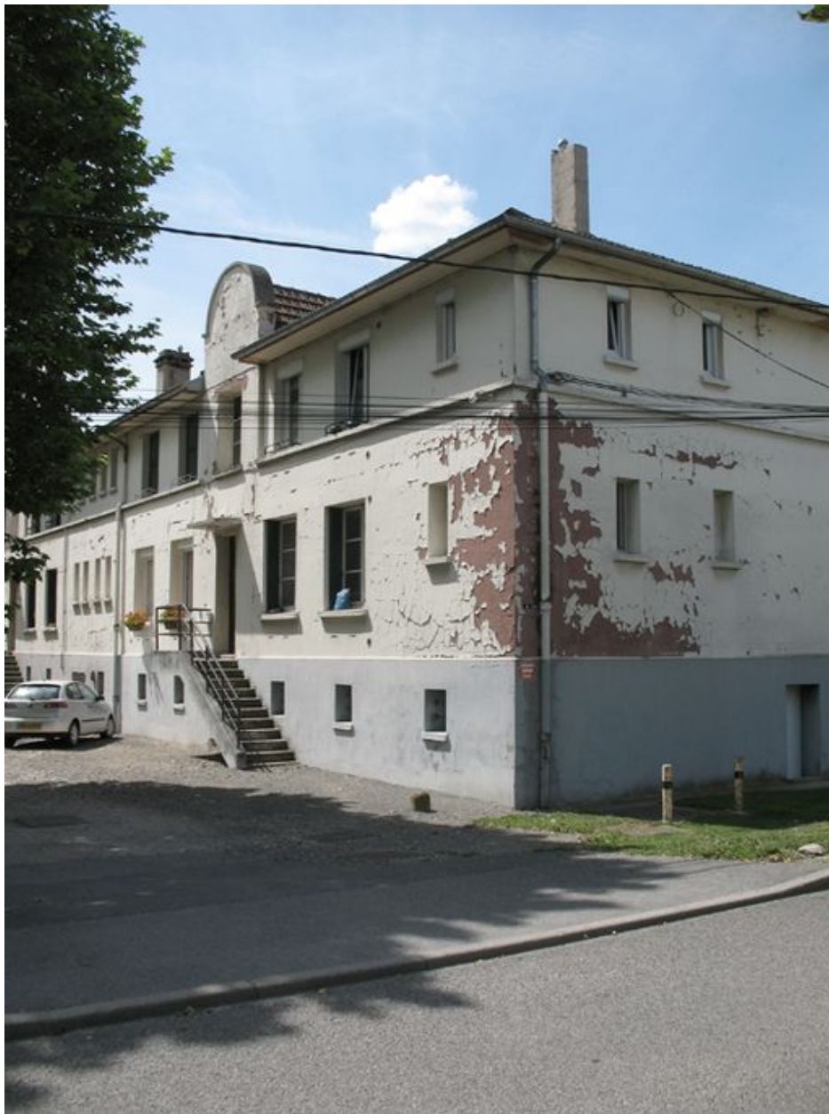
Détail du mur pignon d'une barre de logements.
