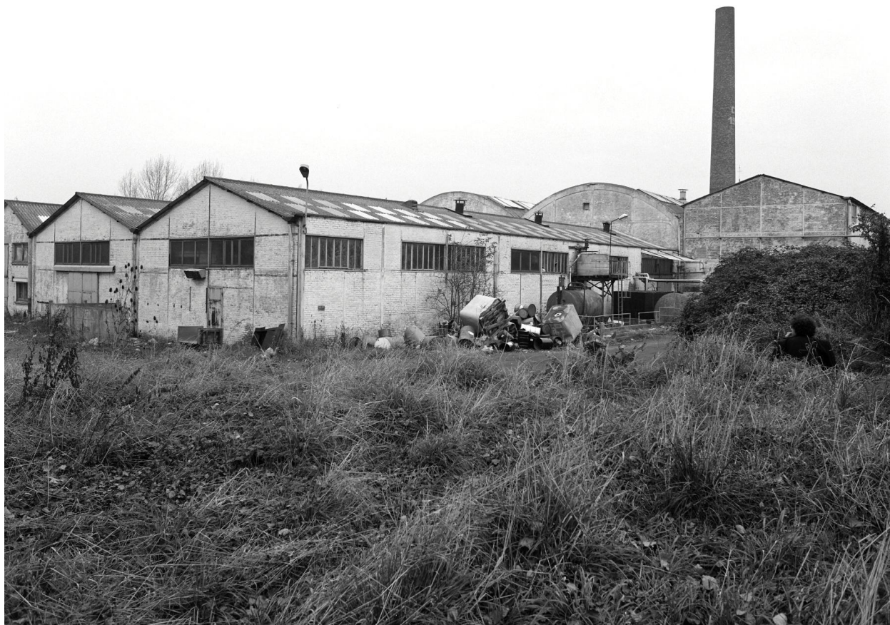
Vue générale prise vers le nord-ouest.
