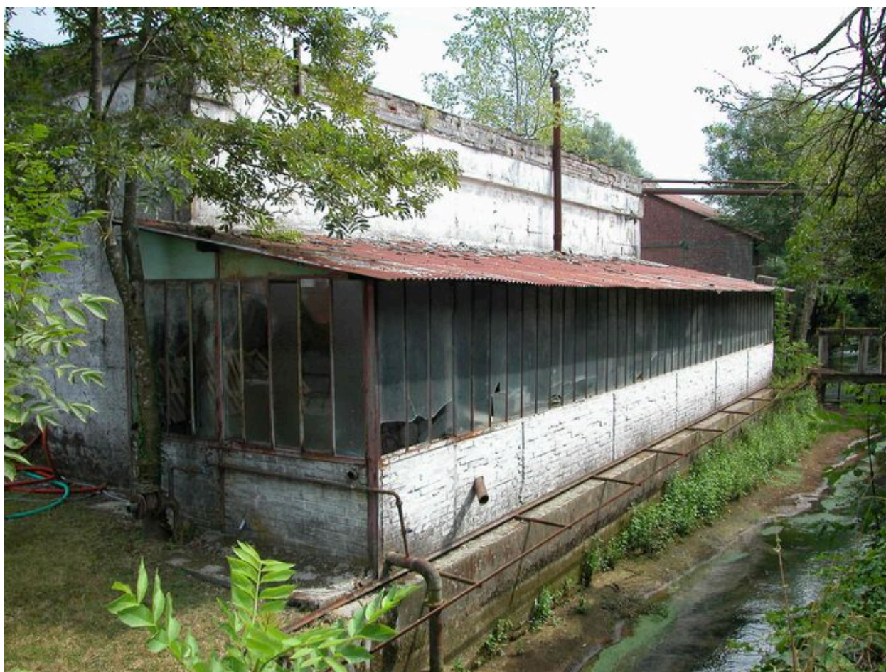
Atelier de rouissage des lins, façade nord.
