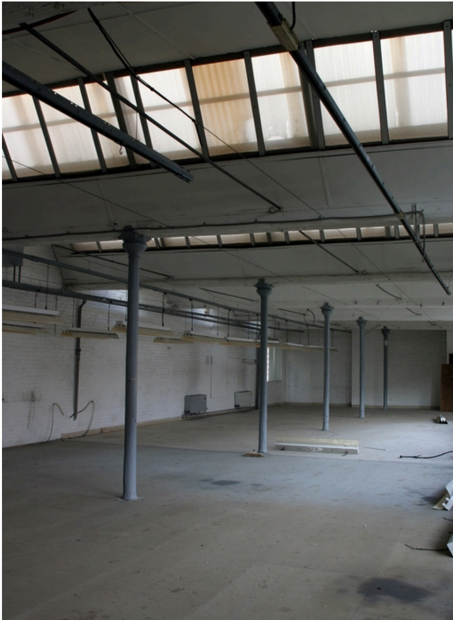
Etage des ateliers antérieurs à 1900 (ensemble ouest) : colonnes en fonte et sheds.
