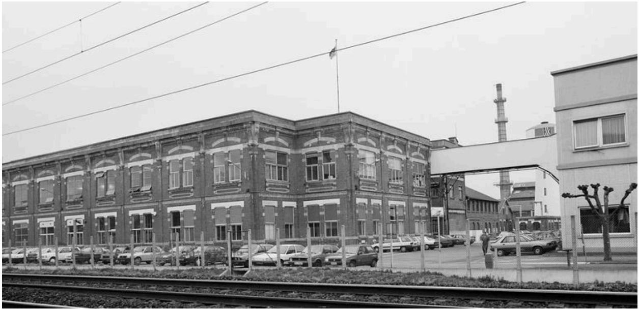
Atelier de fabrication ouest, vue partielle.
