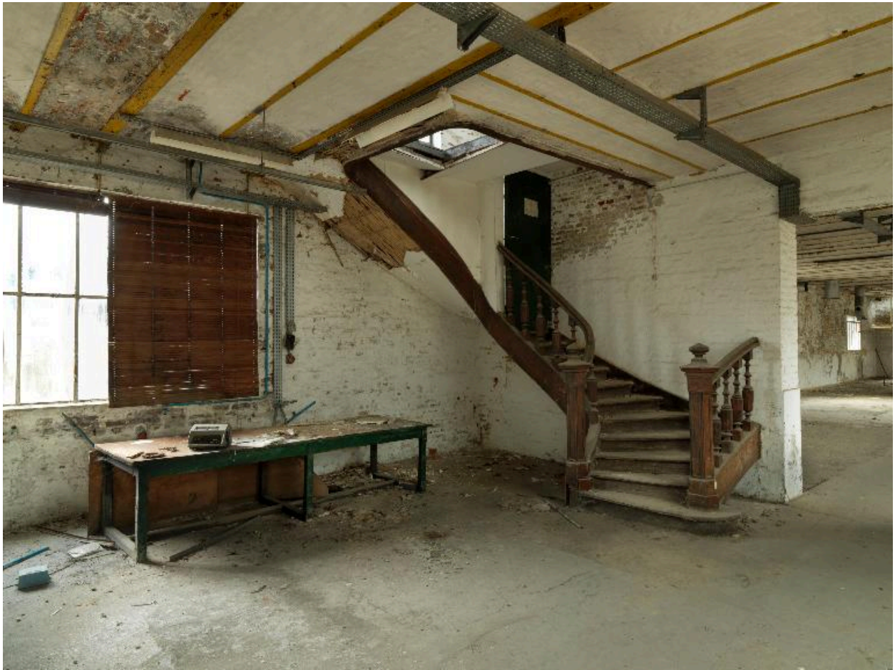
Vue intérieure des anciens bureaux.
