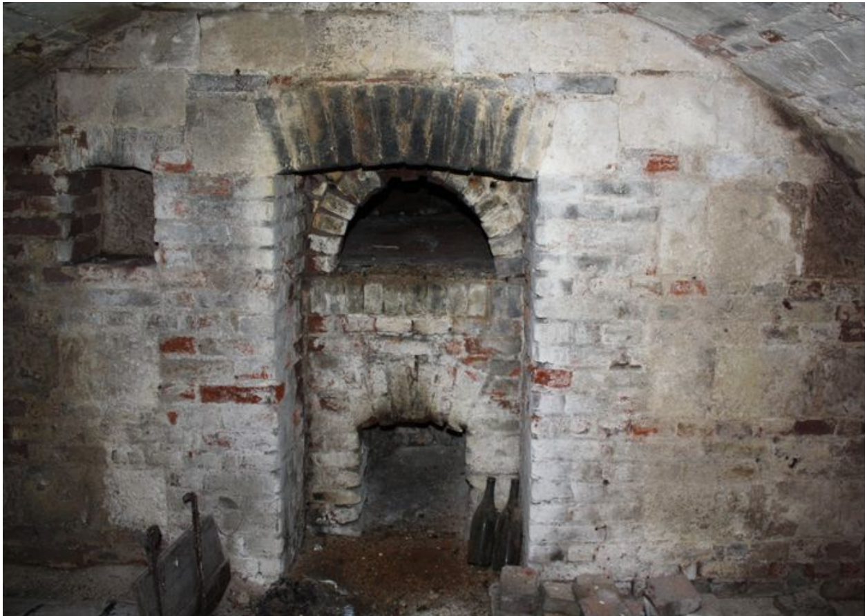
Détail du four à pain logé dans le mur de refend de la cave.
