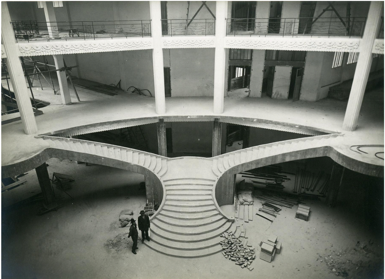
Le grand escalier de l'atrium ovale en construction, détruit en 1933 (Cité de l'Architecture et du Patrimoine ; fonds des Bétons armés Hennebique ; 3-D-370).
