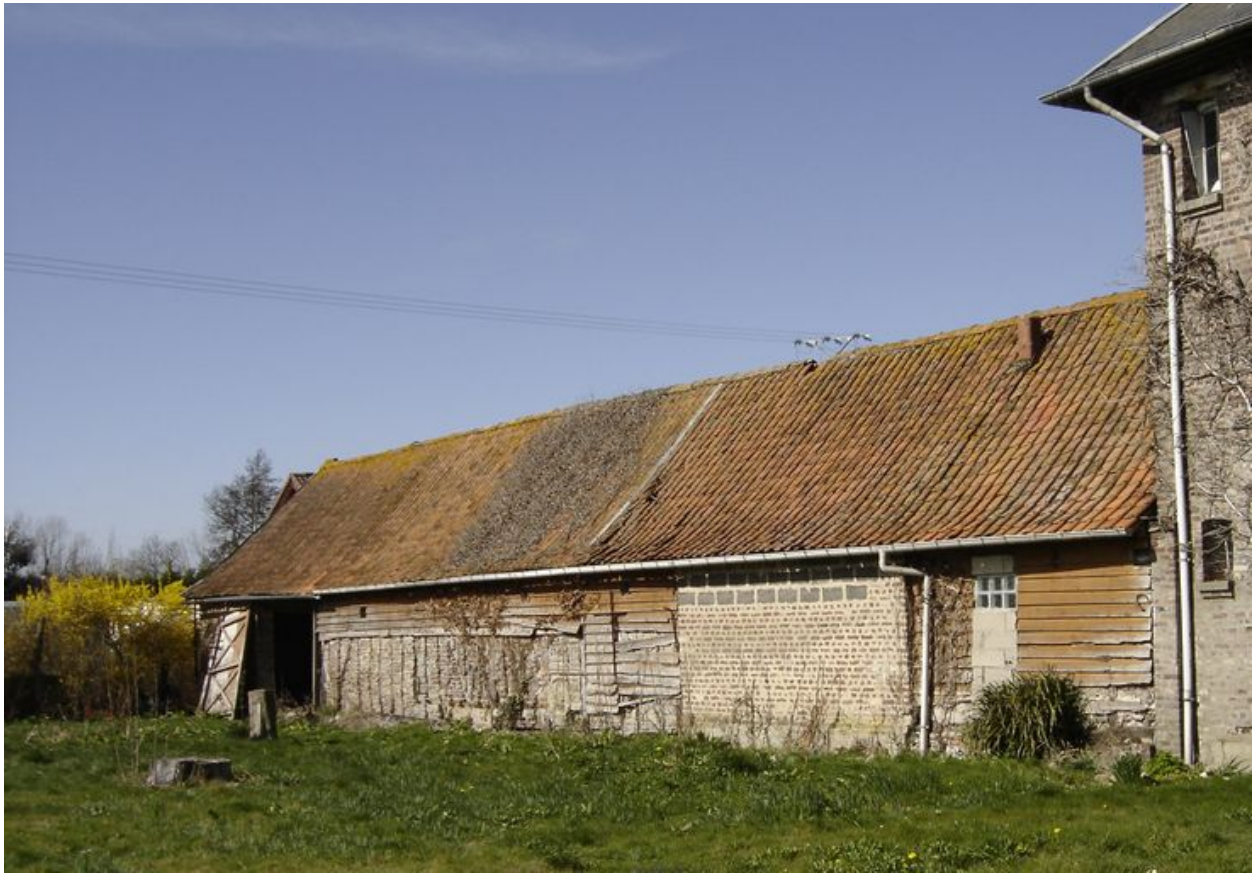
Vue des anciennes dépendances agricoles situées dans la cour, parallèlement au restaurant sur rue.
