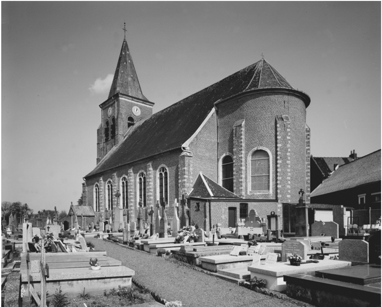
Vue générale extérieure, depuis le cimetière.
