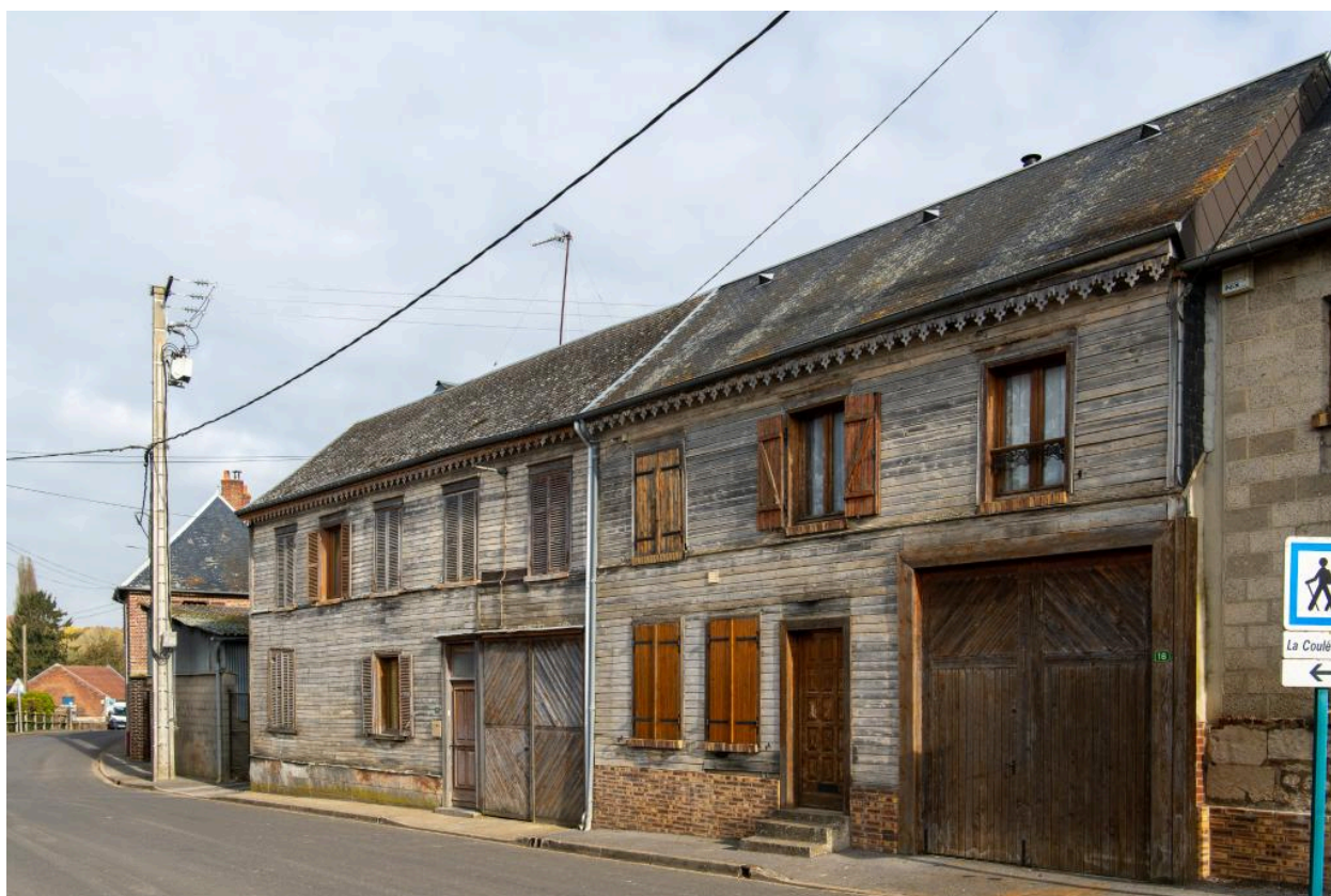
Deux anciens commerces (?), n°16-18 rue d'Amiens, vue depuis le sud-ouest.
