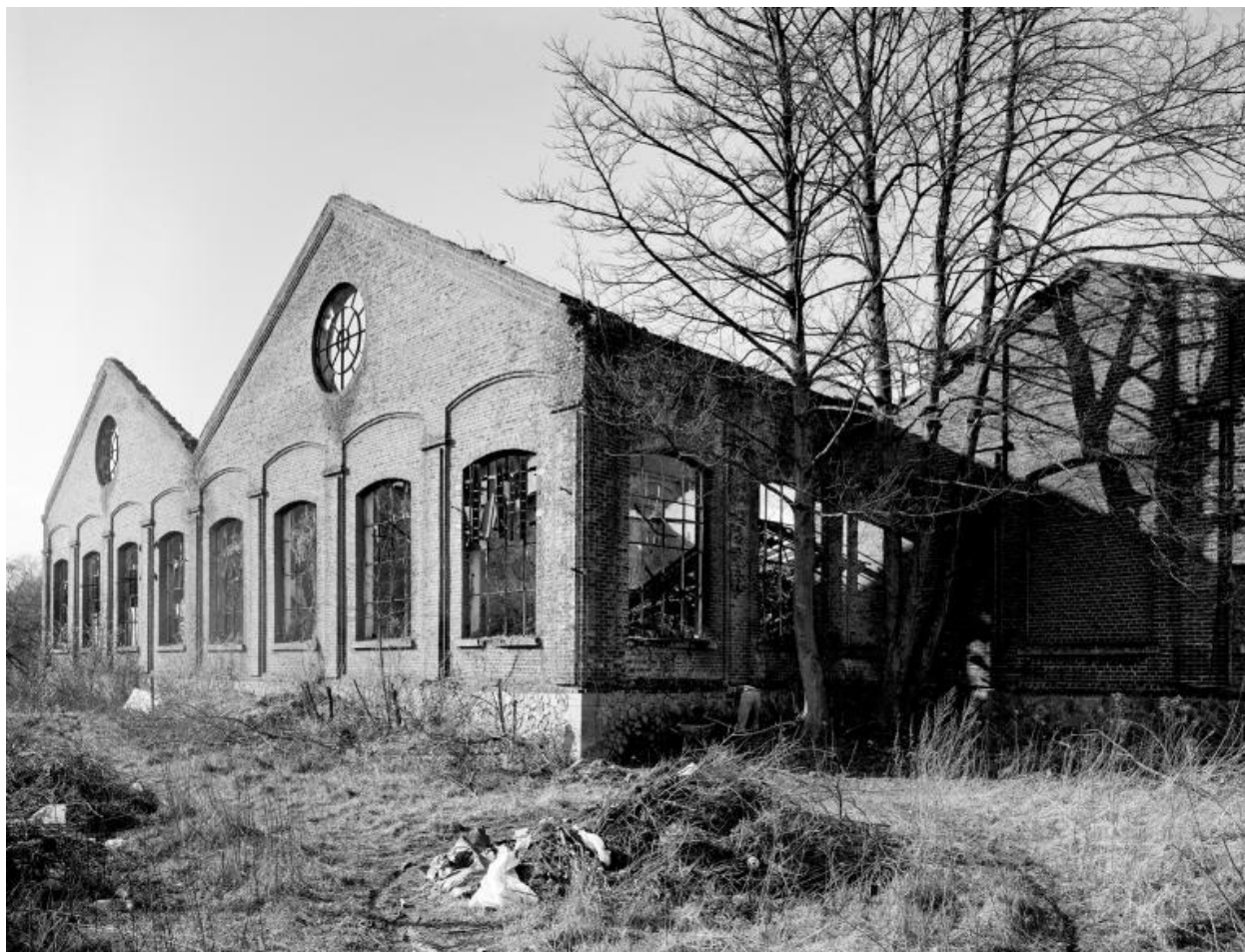
Sous-station électrique. Élévation sur la Sambre.
