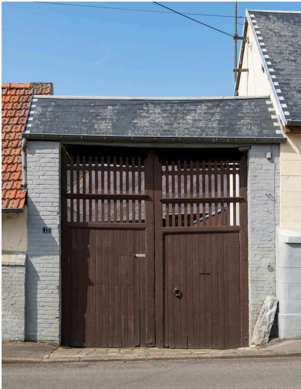
Entrée charretière avec porte monumentale, n°15 rue des Bonhommes, vue depuis le nord-ouest.
