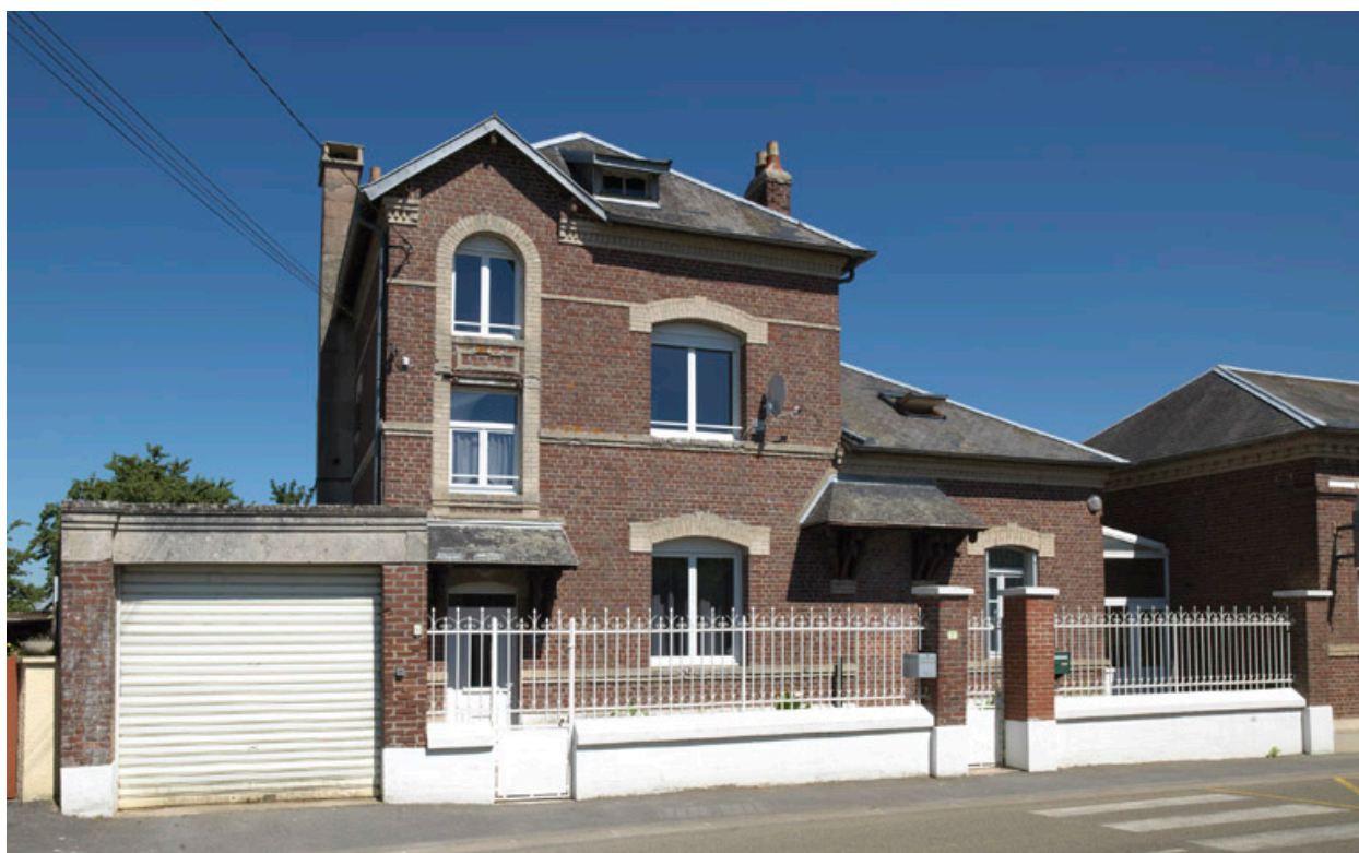
Vue du logement d'instituteur.
