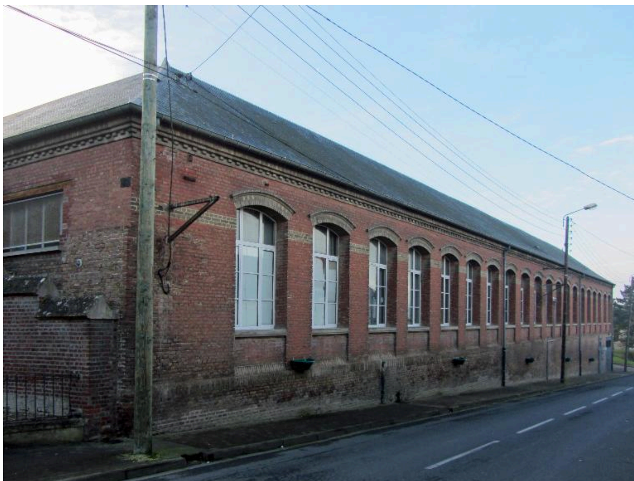
Façade sur rue des salles de classe.
