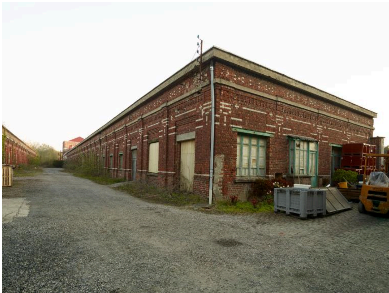
Vue prise vers le nord entre le tissage à gauche et le magasin aux fils à droite.
