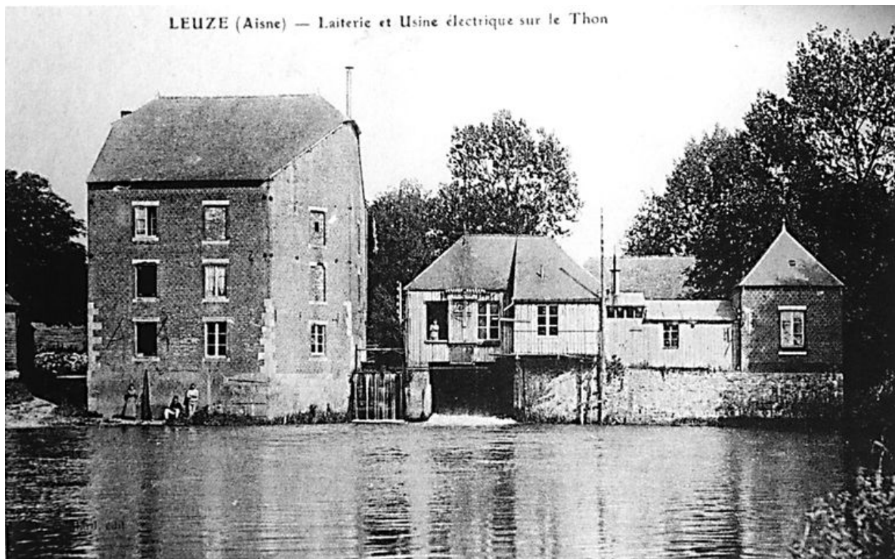
Moulin avec l'usine électrique édifée sur le barrage (AP).
