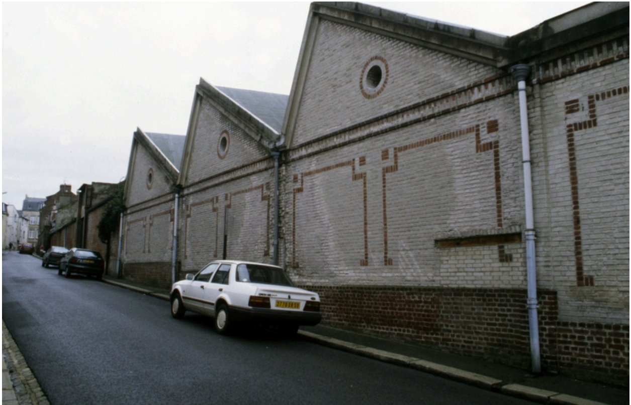
Pignons en shed du magasin aux cotons blanchis (rue de la Grange), 2001.
