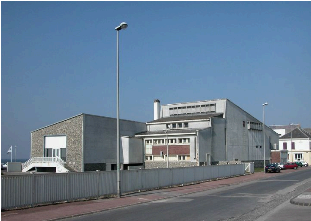
Vue d'ensemble, élévations postérieure et latérale, casino actuel.
