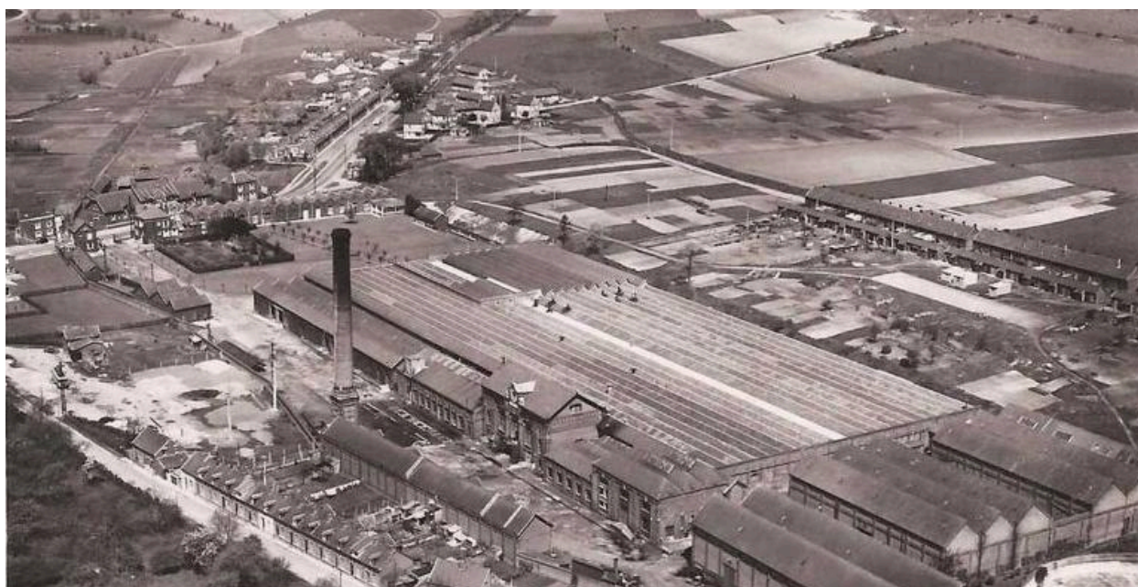
Vue aérienne de l'usine vers 1950 (coll. part.).
