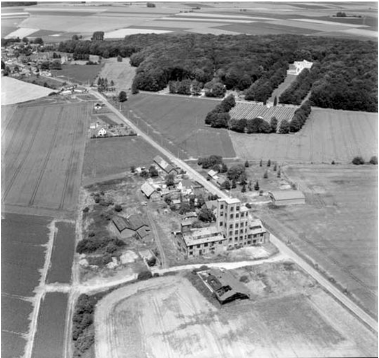
Vue aérienne, flanc sud-ouest.
