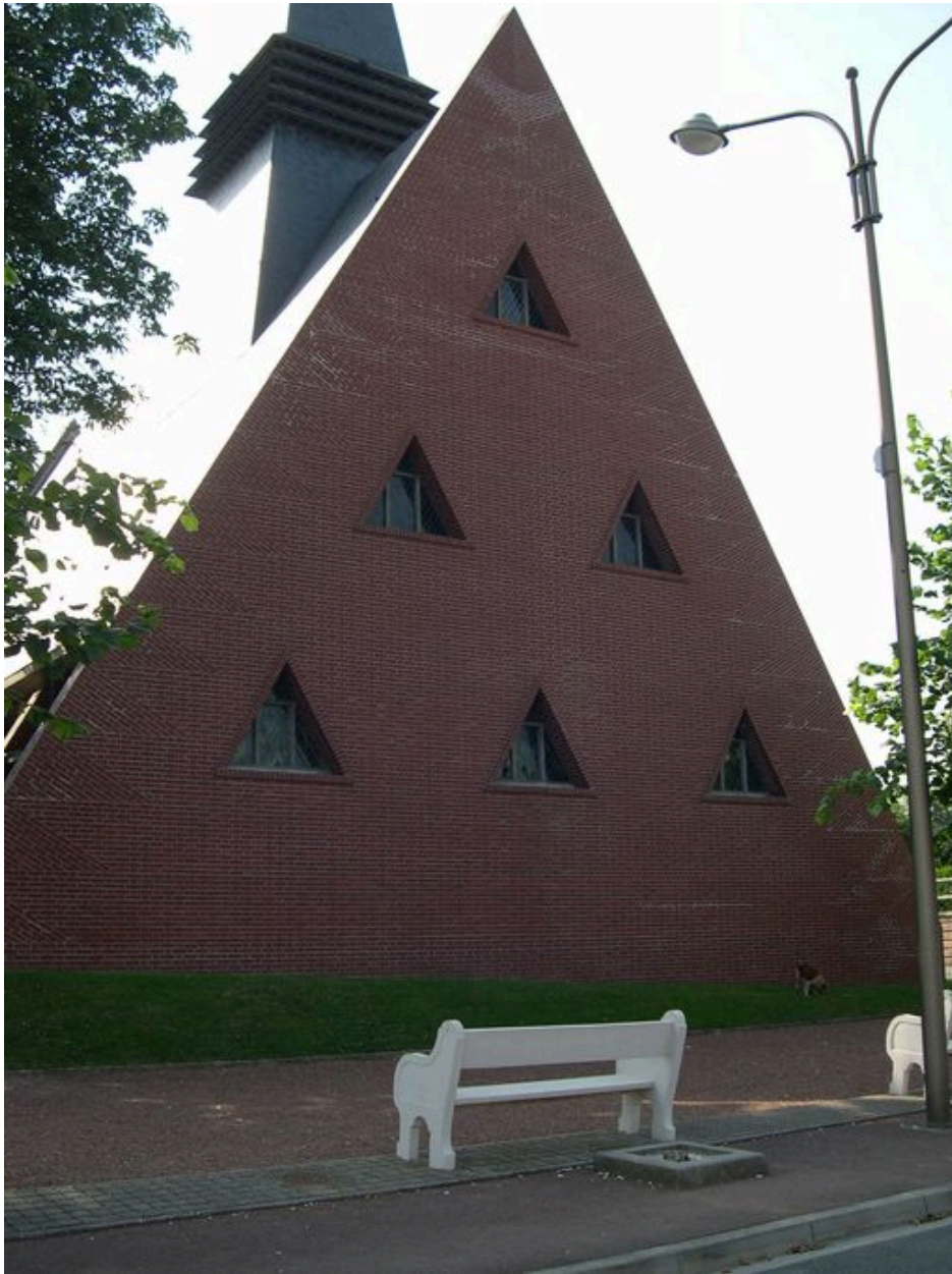
Vue du pignon oriental.
