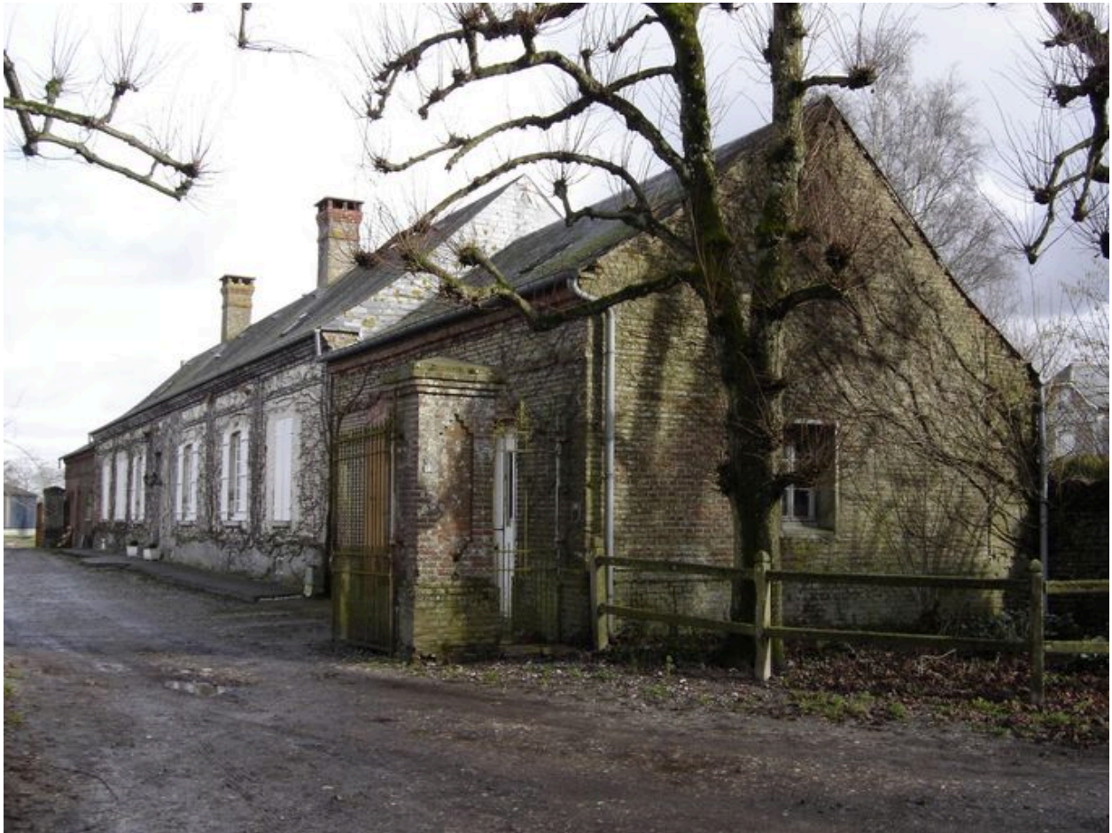
Vue du logis depuis l'entrée sud-ouest.
