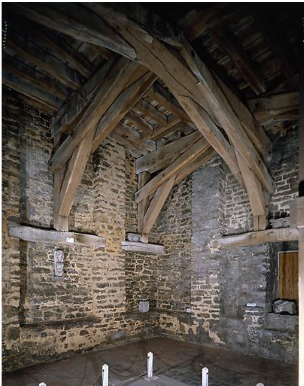
Deuxième étage, charpente : vue générale.
