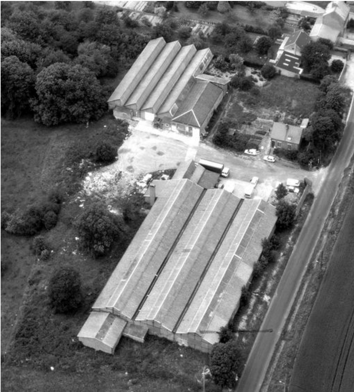
Vue aérienne, flanc est.
