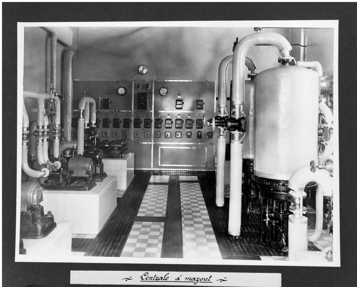
Centrale à mazout, 16 février 1940. Photographe inconnu (coll. part., archives Cerec).
