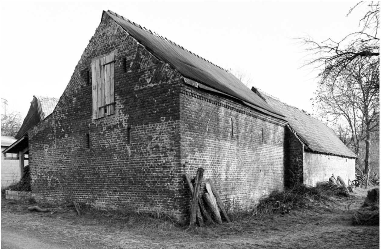
Elévation extérieure des étables depuis le sud.
