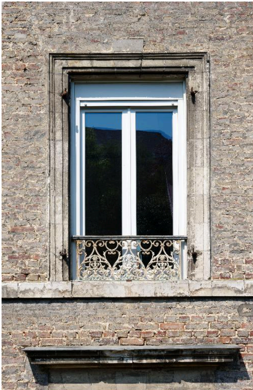
Détail d'une ouverture et de son garde-corps en fer-forgé, premier étage de la façade postérieure.
