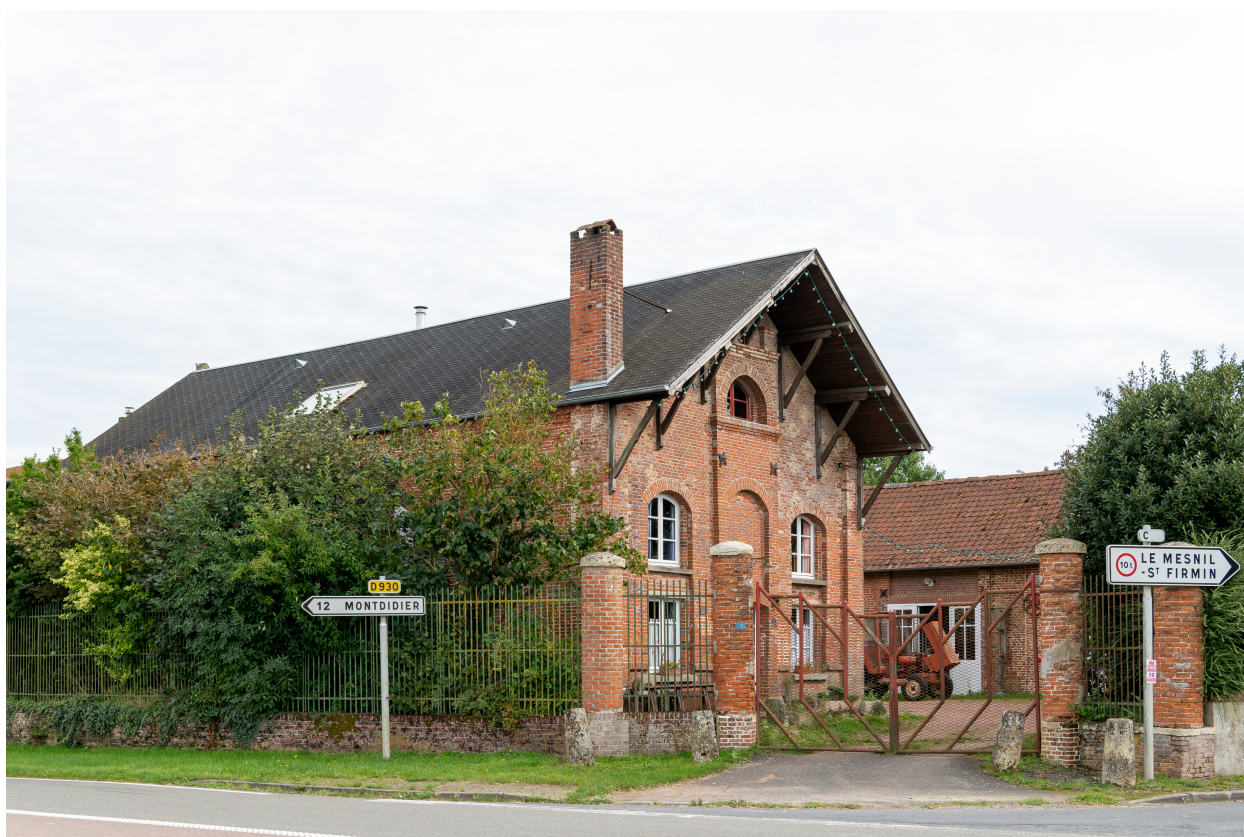
Ancienne fabrique de vitraux Latteux-Bazin, carrefour de la D 930, vue depuis le nord.
