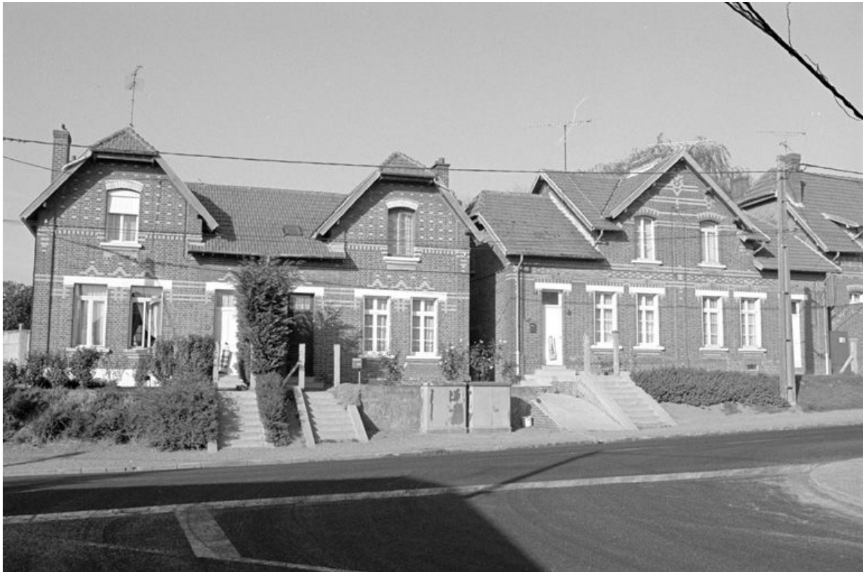
Logement d'ouvriers, vue partielle.
