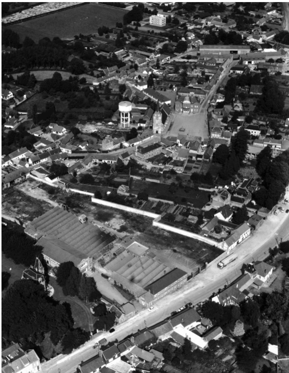
Vue aérienne partielle du village et de l'usine, flanc sud-ouest.
