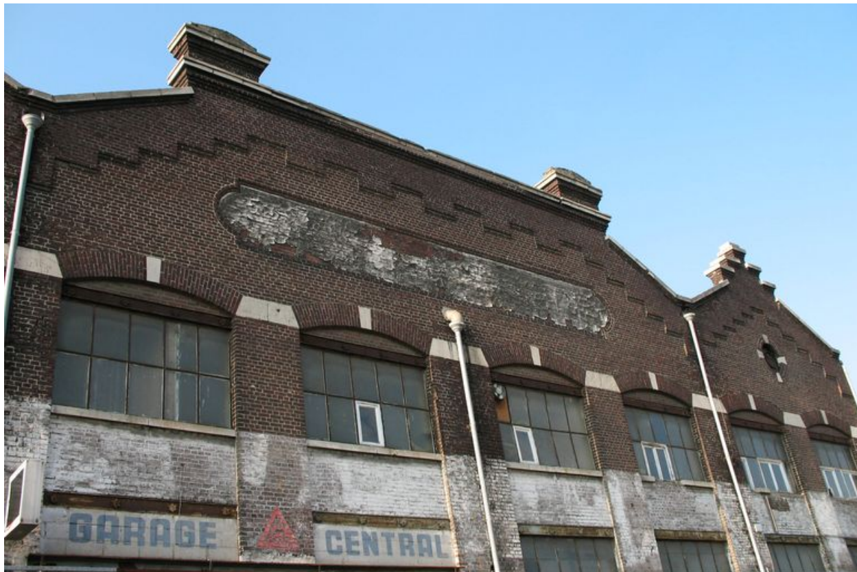
Le mur pignon sur la rue Jean-Jaurès.
