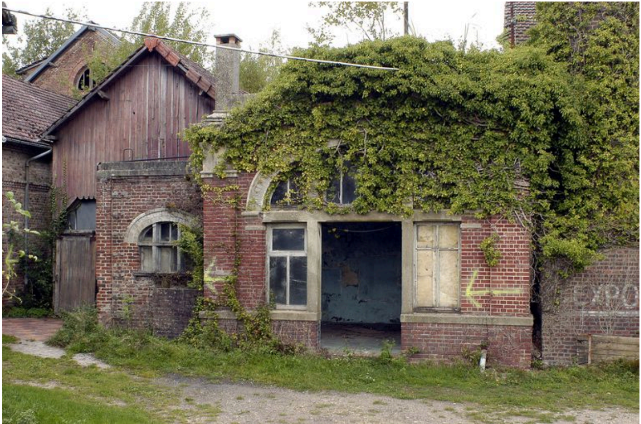
Façade de la salle des machines.
