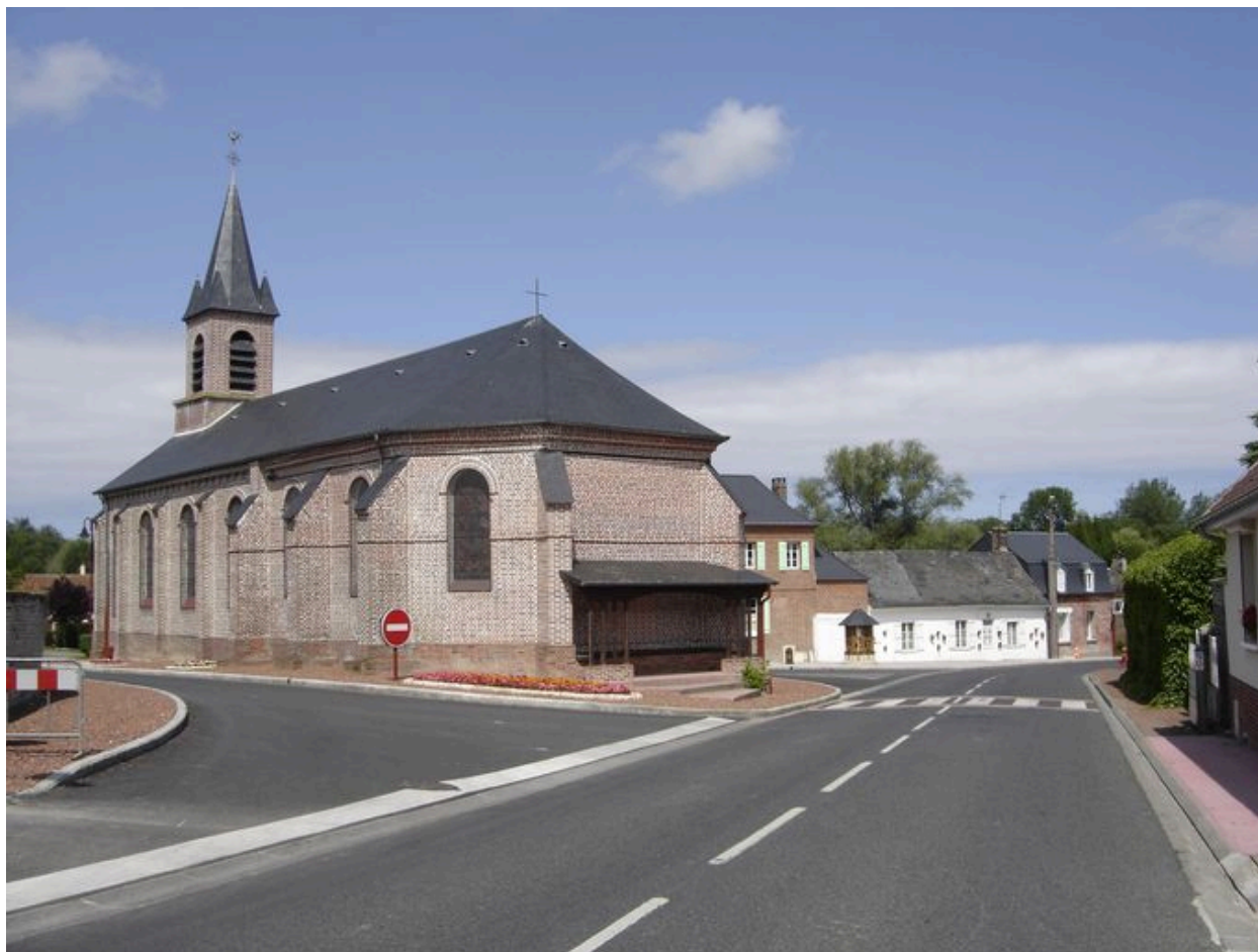
Vue générale depuis l'est.
