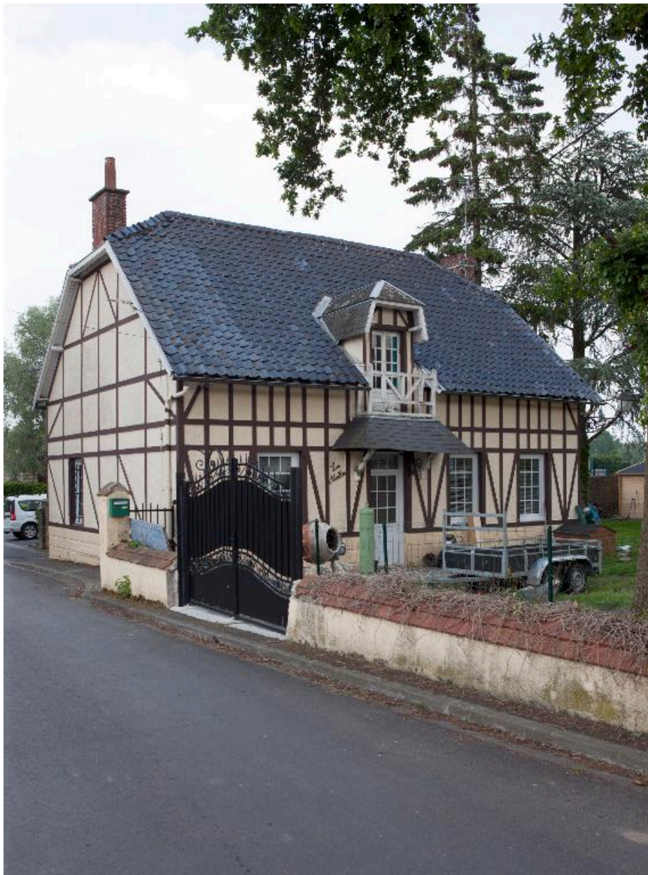
Maison imitant les maisons de villégiature 3 rue du Cimetière.
