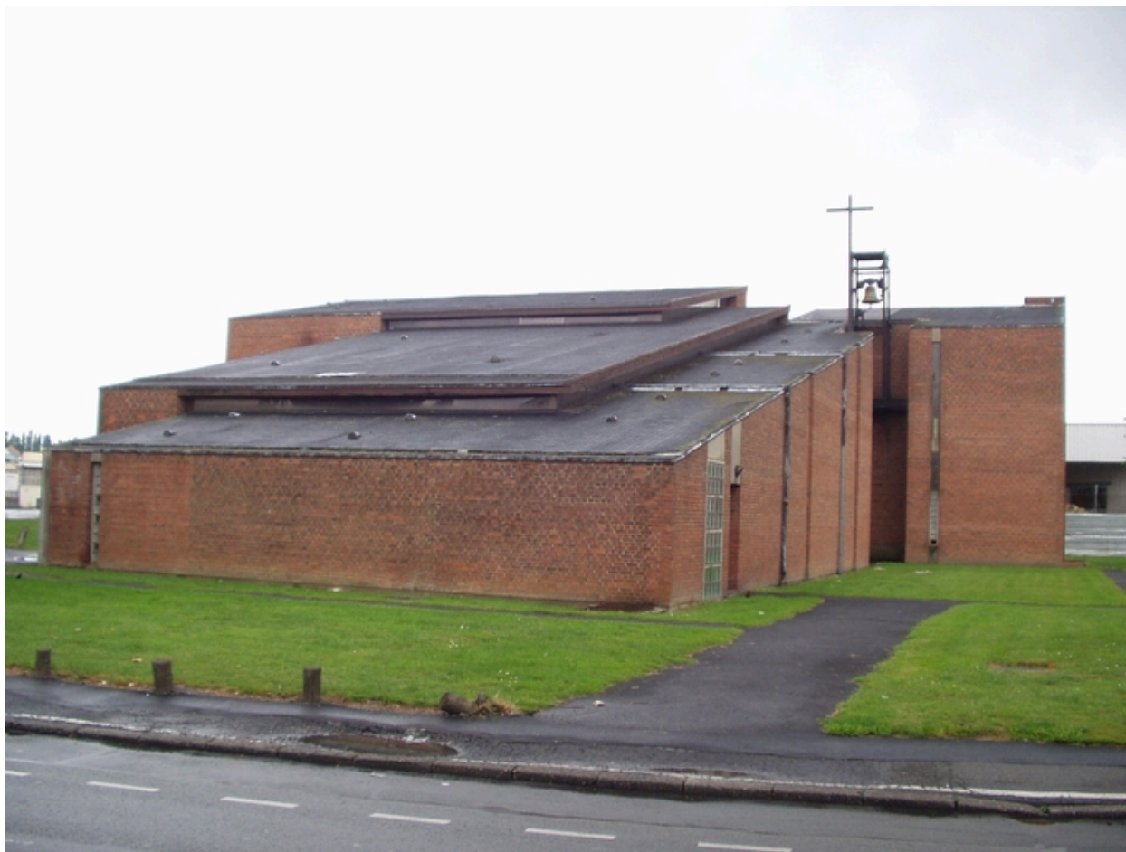
Vue générale extérieure, entrée.
