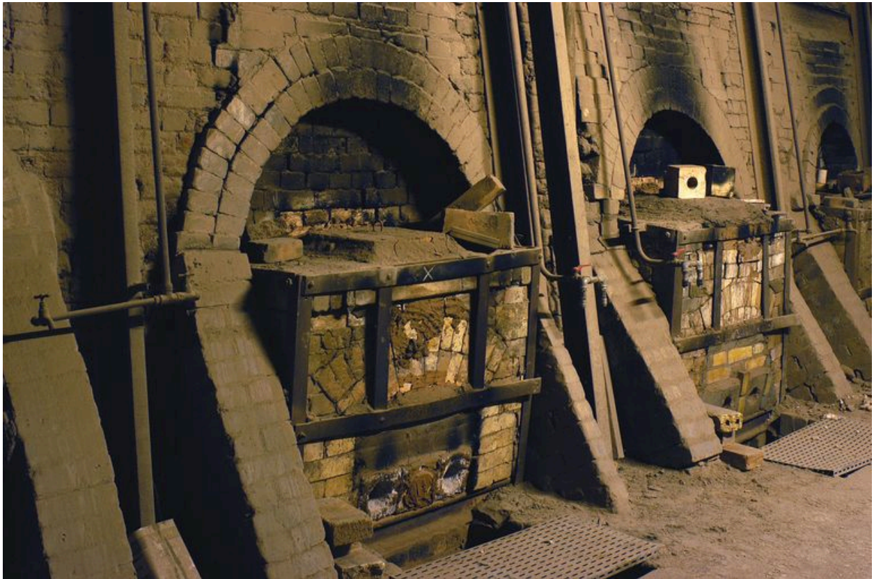
Détail des alandiers du four de cuisson.
