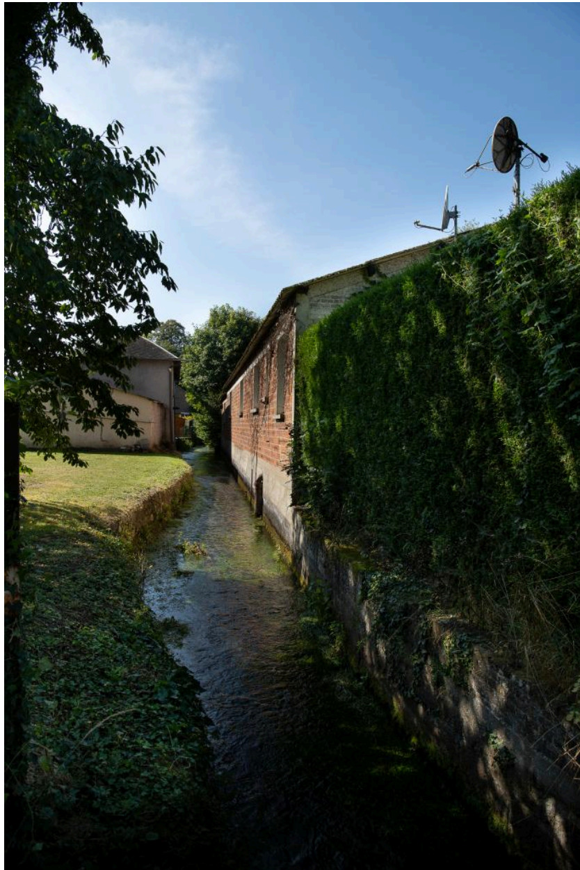
Vue depuis l'est du bras de la Selle passant derrière les anciens bâtiments de la graineterie.
